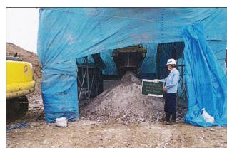
軟弱地盤等で改良が必要な土壤（土質）を固化材で改良（固化）する工事を行います。
