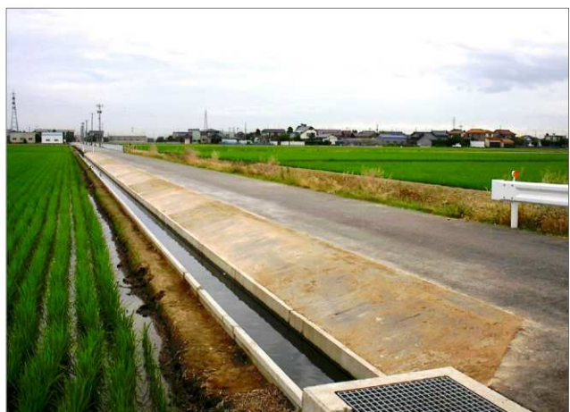
能美市西任田農道路肩工事
