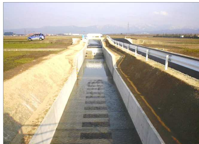
新砂川7-2号線水路工事(H12)
