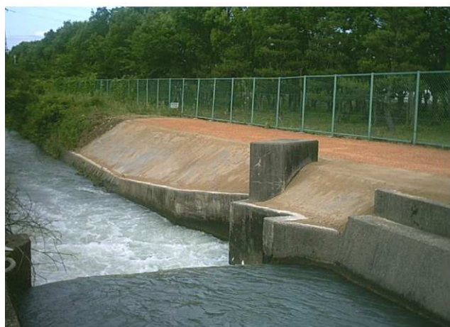
宮竹用水防草工事(H13)
