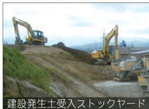
建設発生土受入ストックヤード
